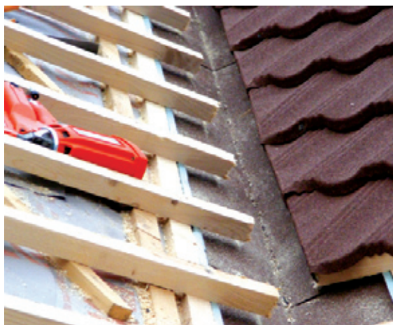
Montarea modulelor in dolie
