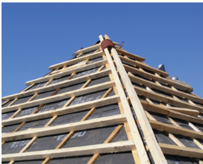
montarea șipcilor la coama rotundă
